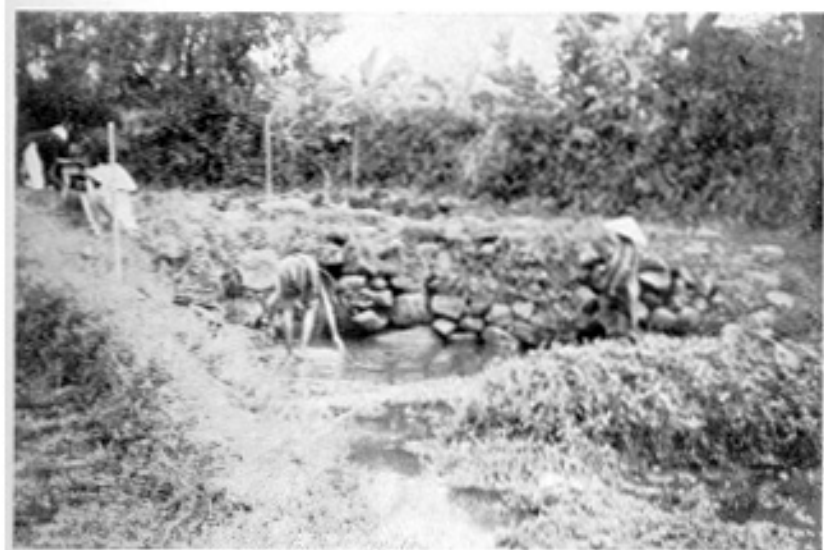
Plancche XXXVII. — Phủ de Vĩnh -Linh.Village de Liêm -Công -Đông. ( en haut ) — Installation Đán. Défluent. ( en bas ) — Installation Môn — Bassin presque stagnant. Armature en pierres brutes, sèches.
