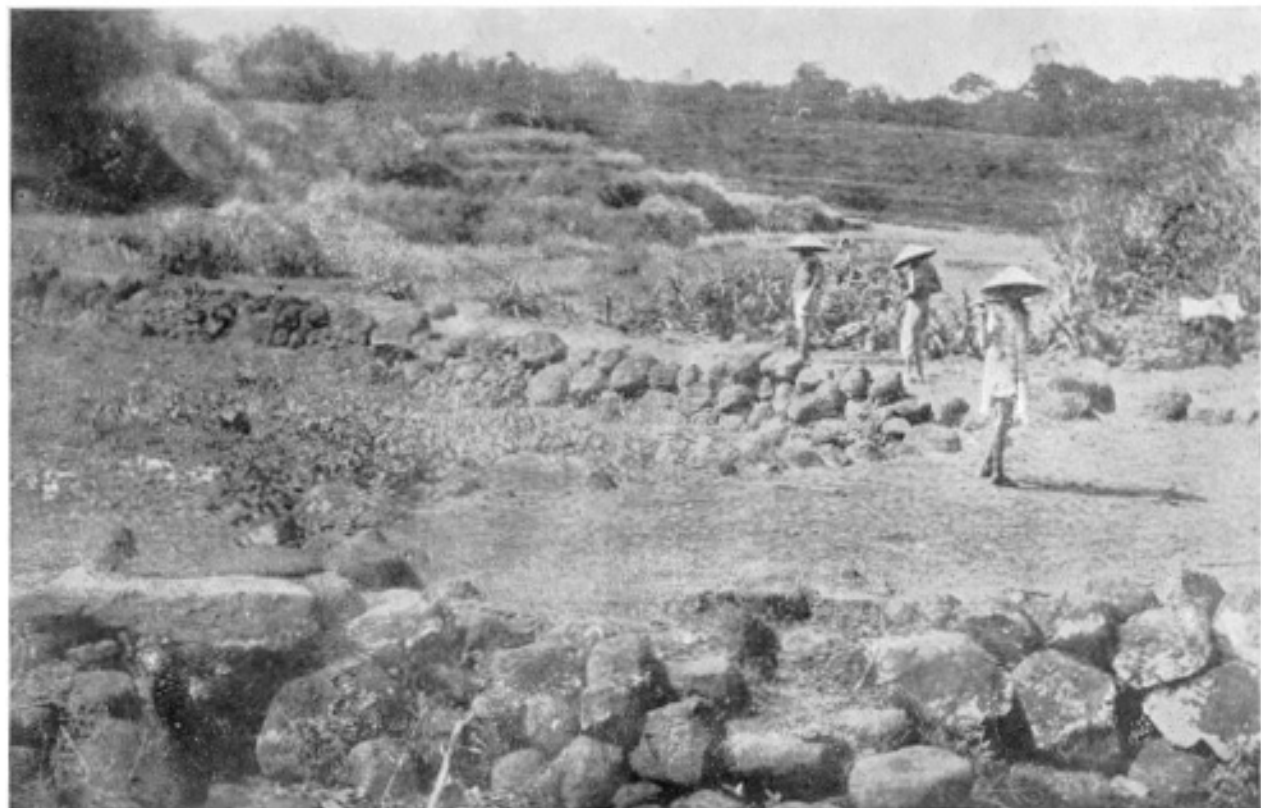
Planche XV. — Huyện de Gio -Linh, Village d'An -Nha — Installation Kinh — Région plate environnant le grand bassin. Au premier plan, mur du fond du bassin d'alimentation ; extrémité d'un bec de cuve, à l'arrière-plan rizières en gradins.
