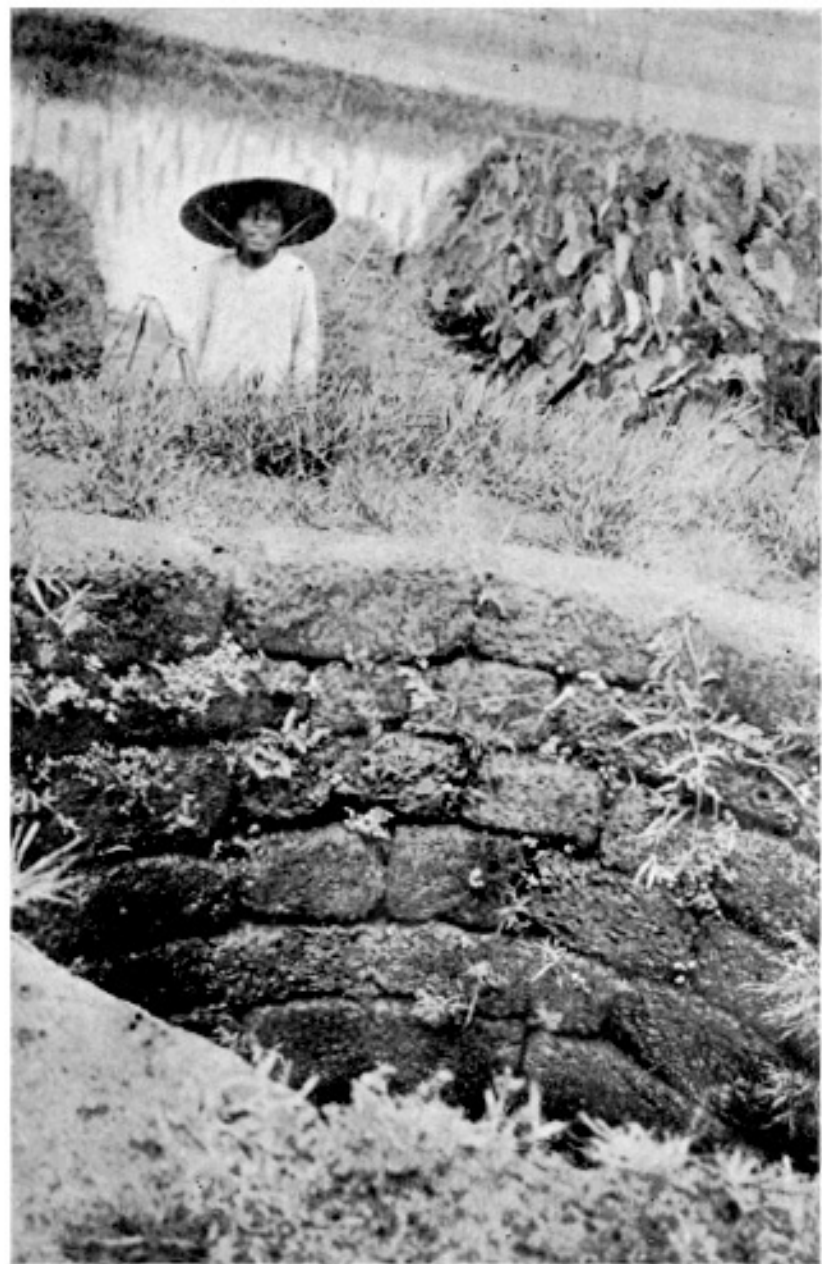
Plancche XL. — Phú de Vĩnh -Linh.Village de Thuỷ -Trung – Puits Biên Kiệp septentrional — Vu de l'Est. Pierres équarées sèches, alternant. Au fond, rizières inondées.
