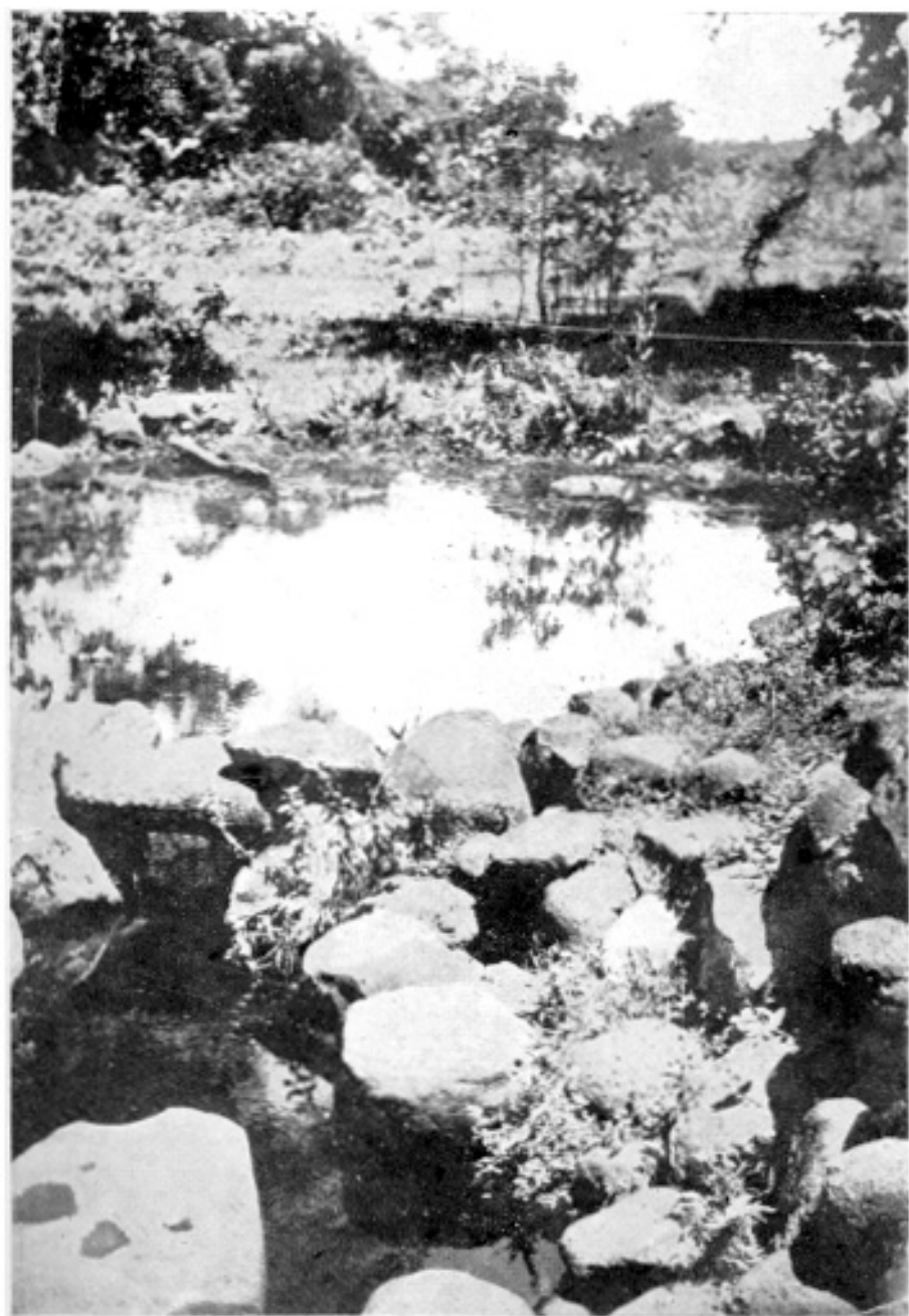
Planche XXVII. — Huyện de Gio -Linh. Village Thanh-Khê — Installation Nậy. — En avant, bassin d'alimentation ( N° 2 du plan ) ; En arrière, troisième bassin ( N° 3 ). Aucun bec de cuve.
