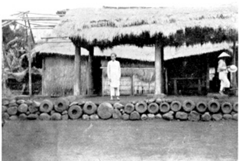
Plancche XXXII. — Huyện de Gio -Linh, Village de Trung -An. ( en haut ) — Installation dite Bassins des Lotus — Bassins inférieurs. ( en bas ) — Pagode du village — Sous les piliers, pierres cylindriques creusées. En avant, même sorte de pierres consolidant la terrasse.
