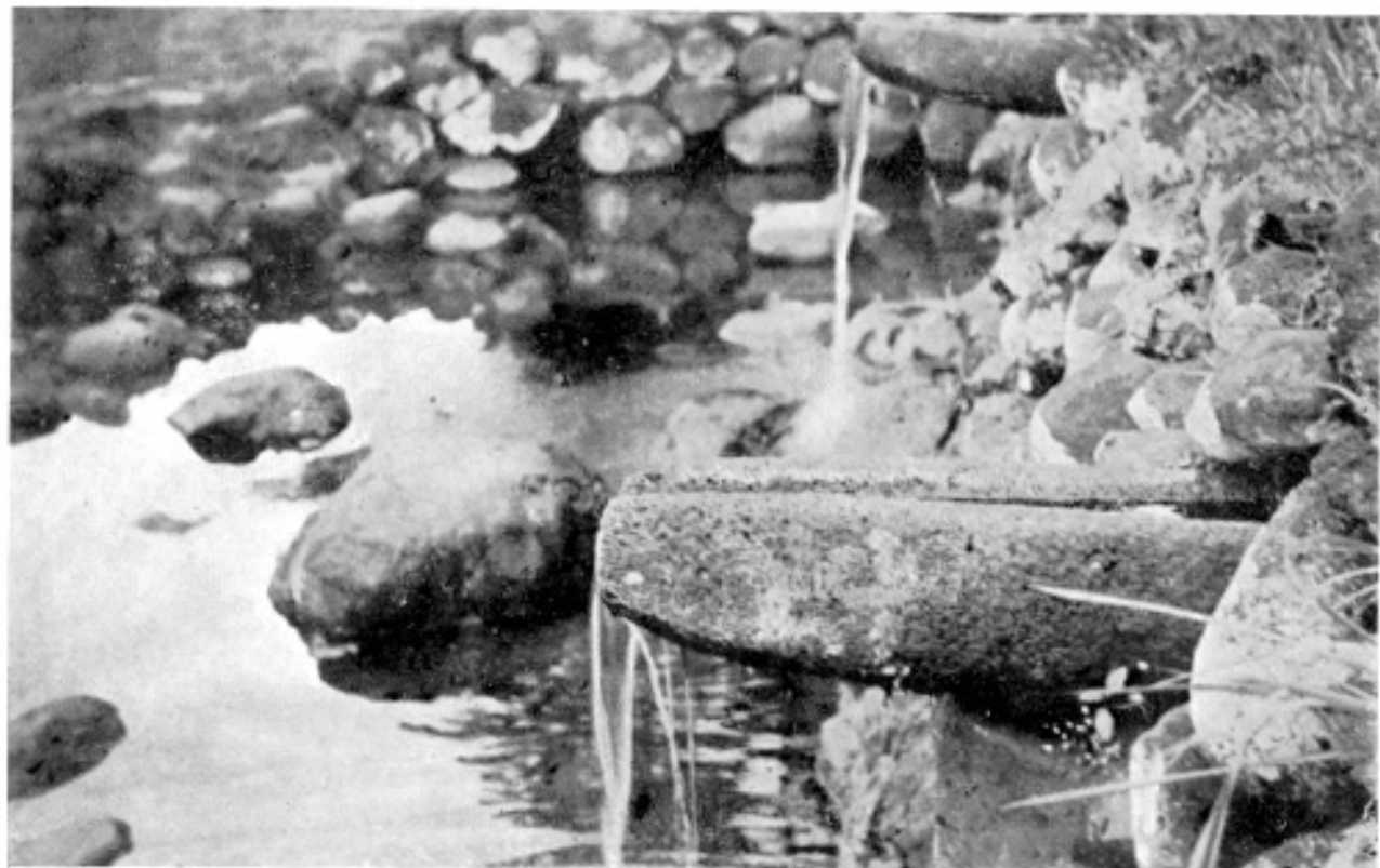
Planche XII. — Huyện de Gio -linh, Village d'An -Nha. — Installation Kinh. — Bassin d'alimentation Au premier plan un bec de cuve en prierre.
