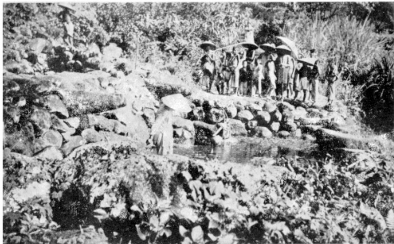
Planche IX. — Huyện de Gio -linh, Village d'An -Nha. Installation Trang — Au milieu, bassin d'alimentation (N° 5 du plan). Deux becs de cuve discernables. A droite, en arrière, terrasse latérale sèche.
