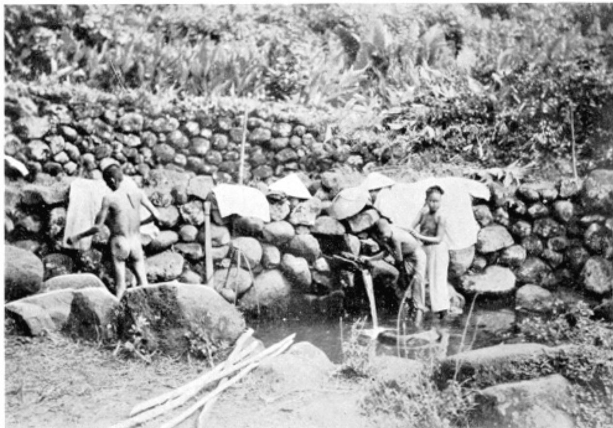
Planche XXII. — Huyện de Gio -Linh. Village de Phương -Xuân. Installation Phương. — En avant, bassin d'alimentation ( N° 5 du plan ), avec son bec de cuve ( N° 4 ). En arrière, bassin supérieur et mur. Une femme racle le dos d'une autre avec un caillou.
