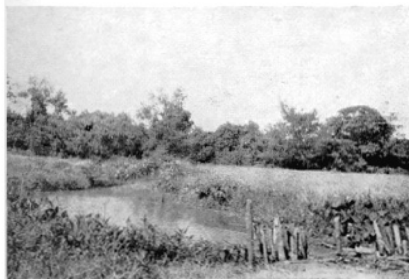
Planche XLV. — Province de Phanrang. ( en haut ) — Barrage Tanon. ( en bas ) — Canal Chai.
