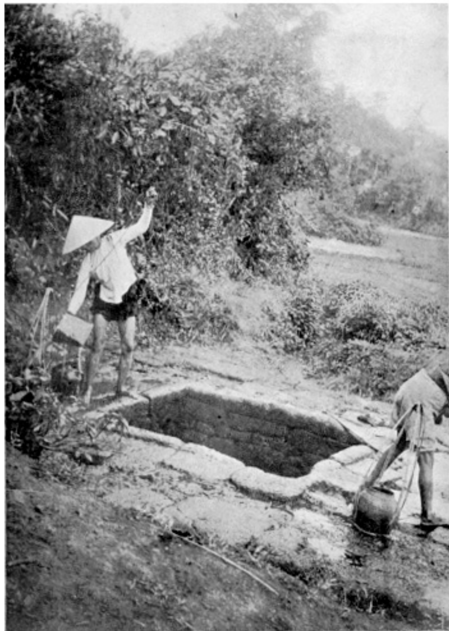
Plancche XXXIX. — Phủ de Vĩnh -Linh.Village de Hoàng -Công — Puits Vinh — Rectangulaire, armature en pierres équaries ; encourage pavé pour éviter la boue.
